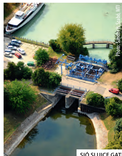
SIÓ SLUICE GATE
